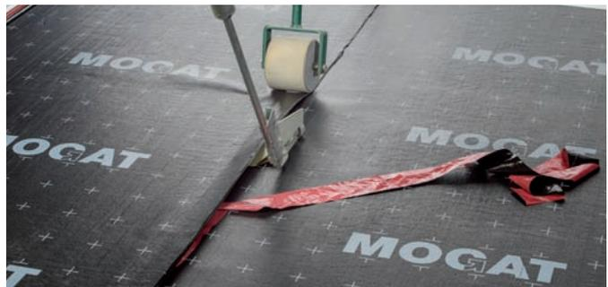
Bei thermischer Aktivierung wird gleichzeitig der rote Nahtstreifen entfernt.
