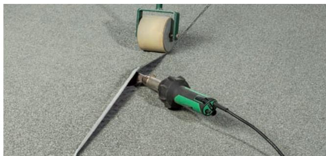
Aktivierung des Thermrands mittels Heißluftgerät.
