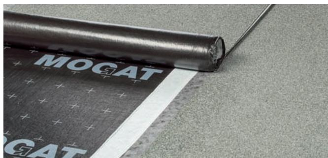
Die RUTEX KSK-OWF ausrollen und ausrichten.
