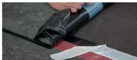
Auf **Beton** zur teilflächigen Verklebung: Entfernung der unterseitigen Ablösefolie. Zur vollflächigen Verklebung: zusätzlich Vent-Folienstreifen entfernen.
