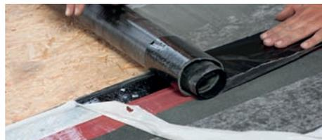
Auf **Holzschalung** verbleibt die Ablösefolie als Trennlage. Die Naht wird zuerst genagelt und nach Ablösung des Randstreifen verklebt.
