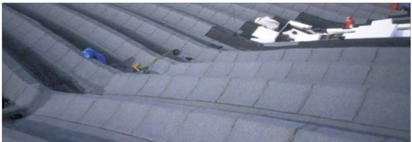
Verlegung der MOGAT ALLIGATORHAUT auf HP-Schalendach
